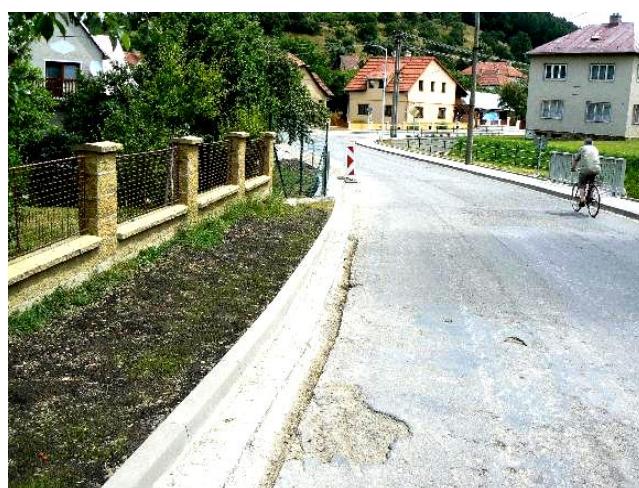
Obrubníky směrem na Nedašovu Lhotu a oprava cesty
